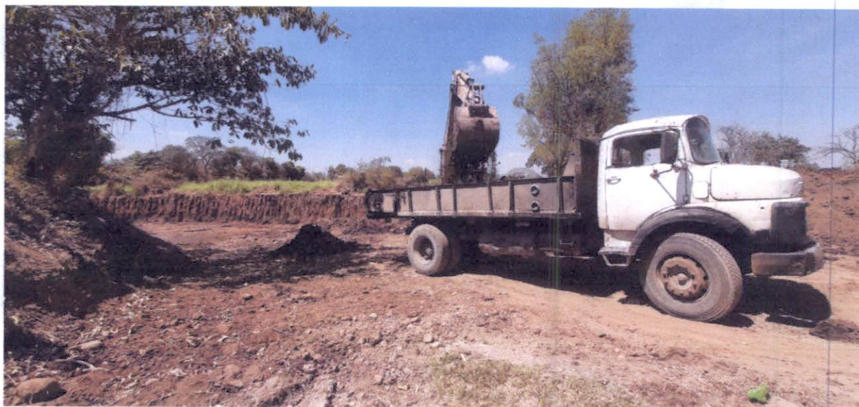
Trabajos de dezasolve de cimacio con una retroexcavadora y camion de volteo.
